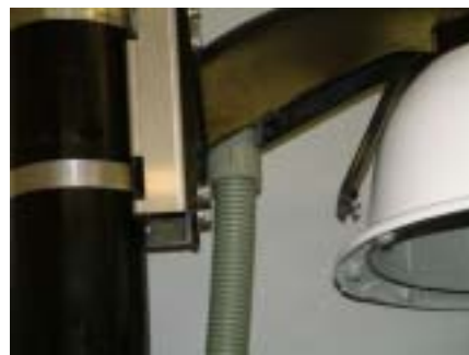
FP 管 CD 管をアームに直接取付ける時はアーム部の穴をご使用下さい
